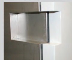
Kerbdurchführung in der Tür
