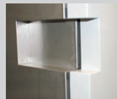
Kerbdurchführung in der Tür
