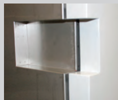
Kerbdurchführung in der Tür
