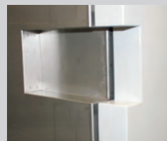
Kerbdurchführung in der Tür
